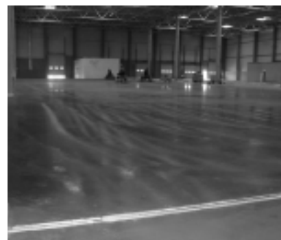
Posadzka bezspoinowa na palach w hali logistycznej Panattoni w Gdańsku – Przejazdowie w trakcie realizacji
